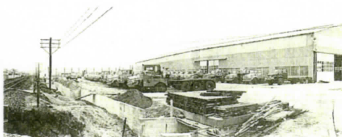
線路をまたいで開発が進む本社工場。左にJ R高徳線の線路が見える
